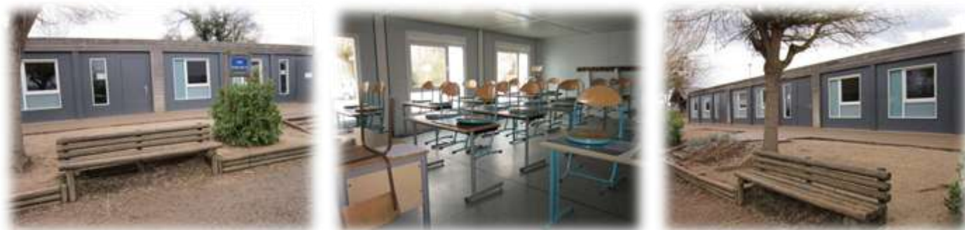
Exemple de bâtiments pour abriter la future classe
